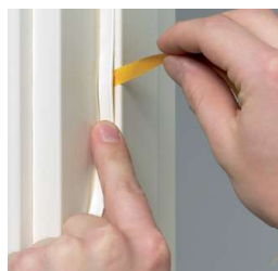
Montering af tætningsliste
